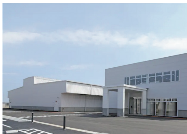
写真1 白井データセンターキャンパス
