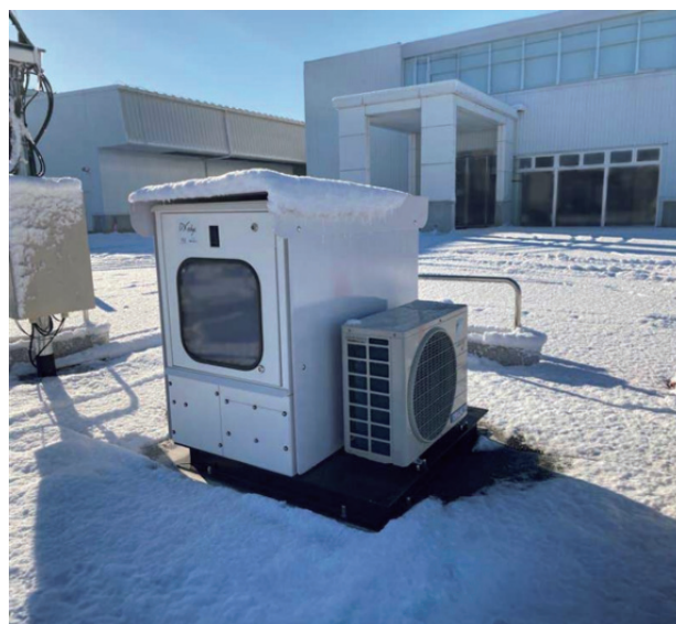
写真4 マイクロDCの設置例
