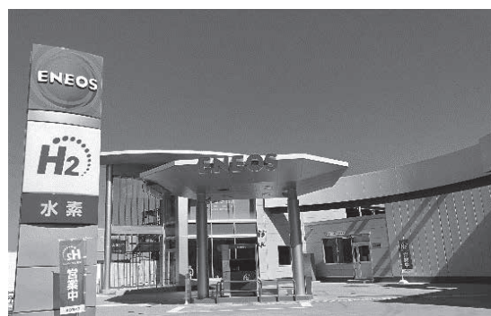
図1 横浜綱島水素ステーション
