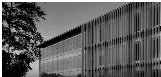
横浜第1データセンター
