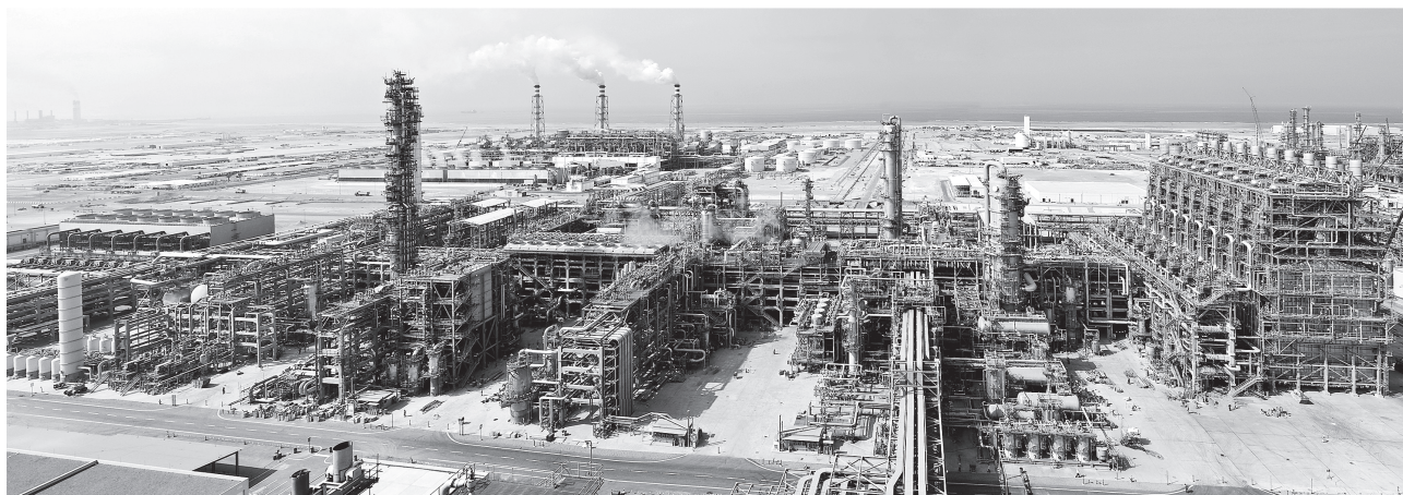
ラービグのエチレンプラント全景
