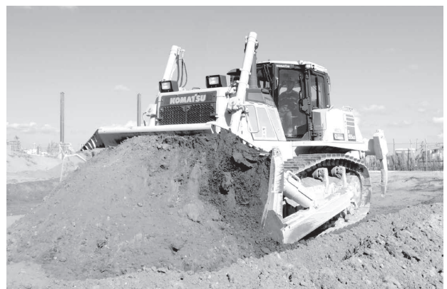
写真3 ICTブルドーザ
