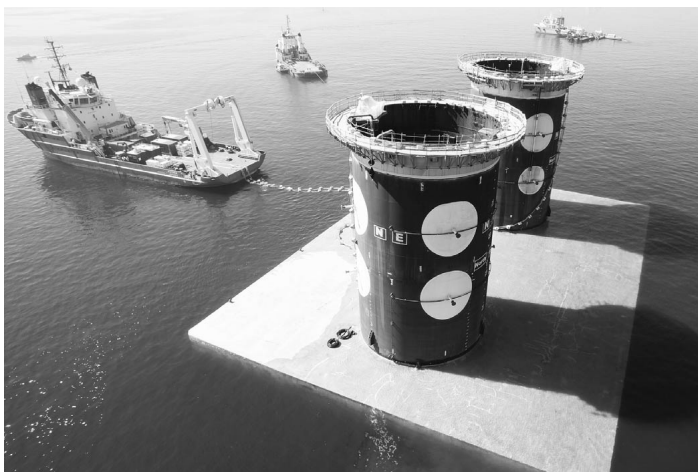
海中に沈設中のイズミット橋ケーソン（2014年3月）
