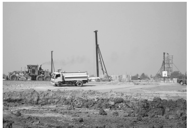
GNS建設現場2
