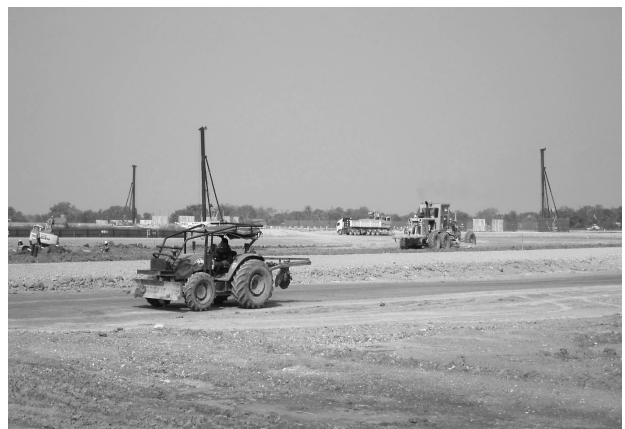
ノンセン ガス火力発電所（GNS）建設現場1
